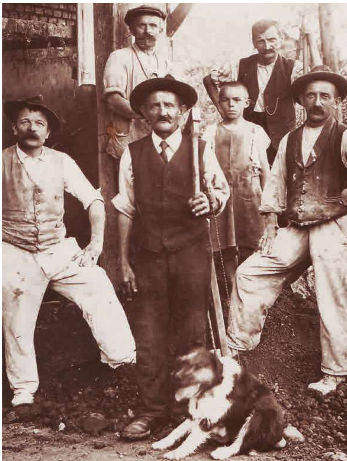
Der 1893 aus Verona eingewanderte Guido Copat (links) auf dem Bau (um 1920). (Foto aus Privatbestand)
