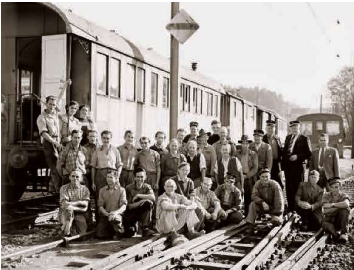
AMP Armeemotorfahrzeugpark, 1955. Gleisarbeiter der Baufirma Suremann W. & Co. (Fotograf: Albert Walder)
